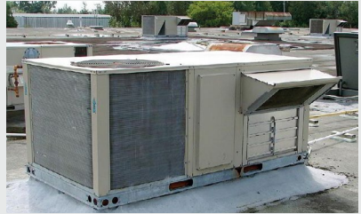
Refroidissement assisté par l'énergie
