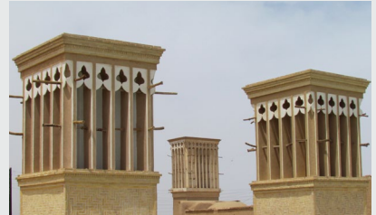
Refroidissement bioclimatique, baghirs, Iran
