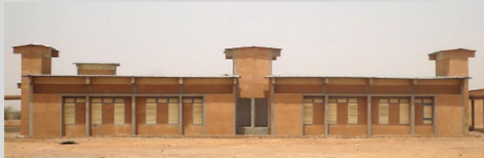
Cheminées solaires, Coopération luxembourgeoise au Niger, 2016
